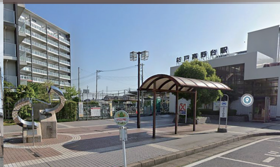
タイル補修から舗装工事に付帯工事提案実施
